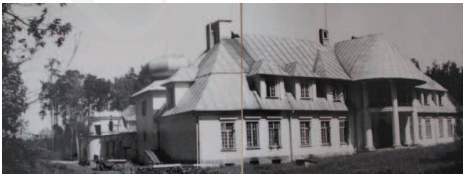
Ilustracja 6. Widok na główną elewację zewnętrzną pałacu w Adampolu. (Fot. Z. Nawrocki, 1980, PKZ Toruń, neg. 7784/15.)
