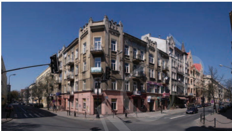
Ilustracja 11. Kamienica przy ul. Chopina 15. Fot. P. Maciuk 2010.
