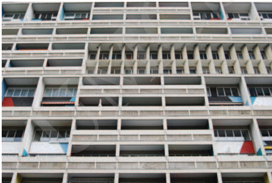
Ilustracja 11. Relief elewacji Jednostki Berlińskiej, fot. A. Pilip (2010).
